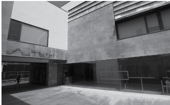
Sutegiren efizientzia energetikoa hobetuko dute, bi solairuak bereiztearekin batera. Lanok aurten bideratzea aurreikusia du Usurbilgo Udalak.
