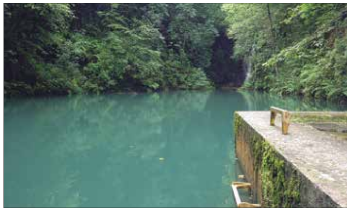
San Esteban depositua 1 eta Eroizpeko (irudian) iturburuak lotzen dituen hodia berrituko dira. Argazkia: Usurbilgo Udalak.
