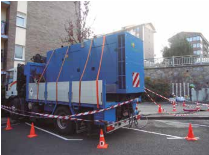
Urriaren 20an, generadore baten matxurak eragin zuen argi mozketak.
