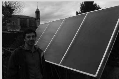
Zubietan, Unai Agirreraren etxean, ura berotzeko argindarra edo gasaren beharrik ez dute. Lau eguzki panel jarri dituzte, ur depositu handi bat eta egurra berotzeko galdara.
